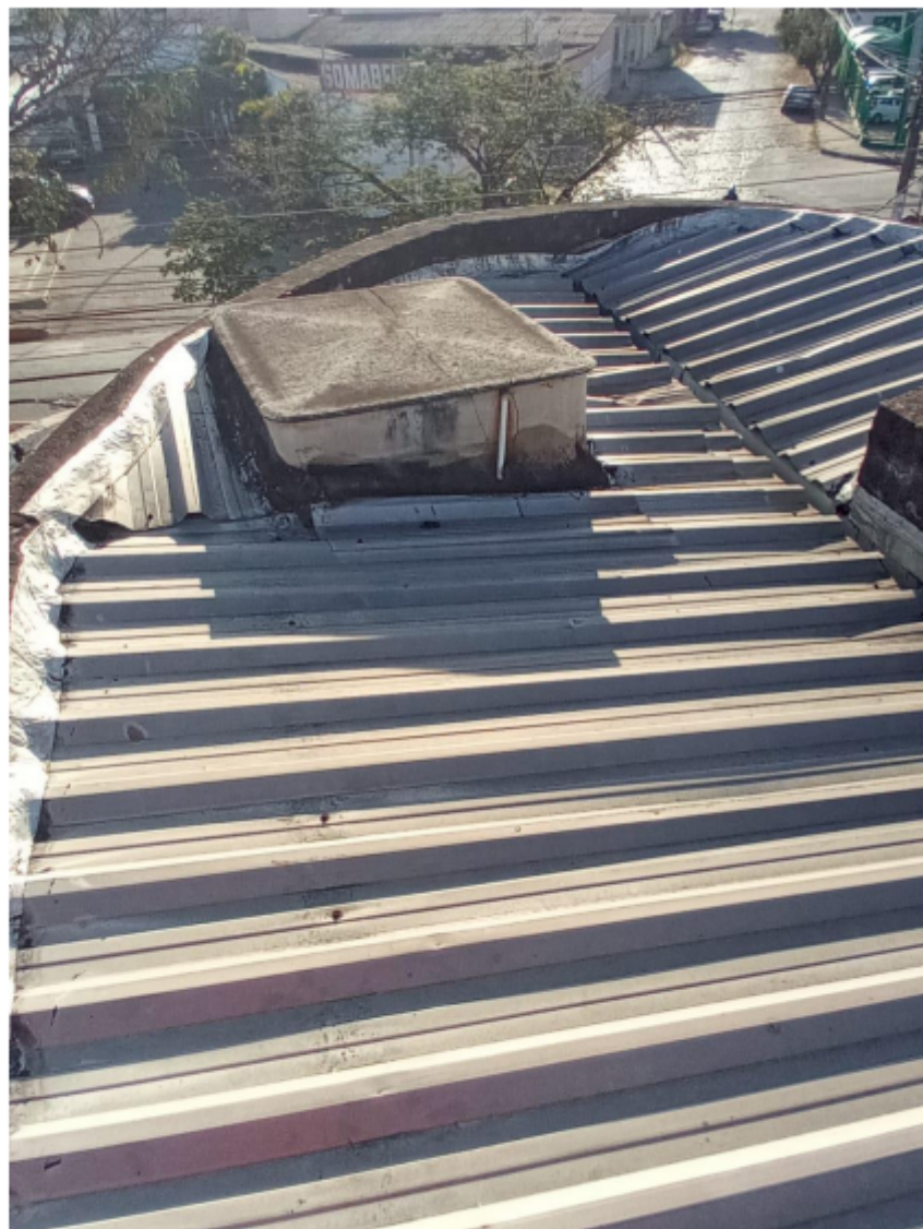
Fotografia 5: Imagem do telhado.
