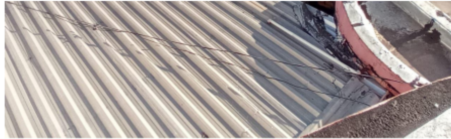
Fotografia 4: Imagem do telhado.
